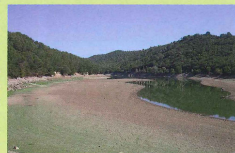
Barrage de Carces
