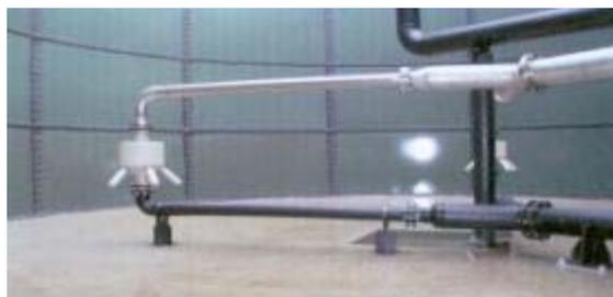
Ce système est proposé pour sa robustesse : hydroéjecteurs préfabriqué en polypropylène (durée de vie normale 20 ans) et tuyauterie inox ou PEHD. Toutes les pièces sont statiques, réduisant de risque d'usure. Enfin, les parties mécaniques (pompes) sont extérieures aux bassins, facilitant la maintenance du système.
