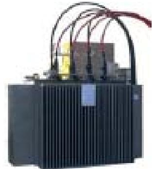
Les transformateurs sont installés sur des bacs de rétention à extinction naturelle pour répondre aux prescriptions de la norme C13200
