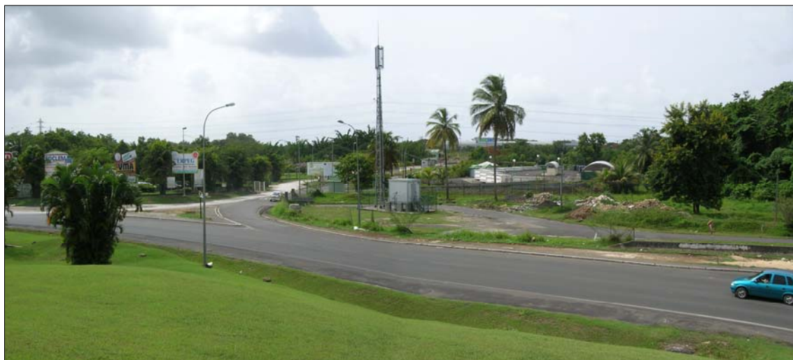
Vue de l'entrée de la Gabarre depuis l'échangeur de Grand-Camp – RN1
