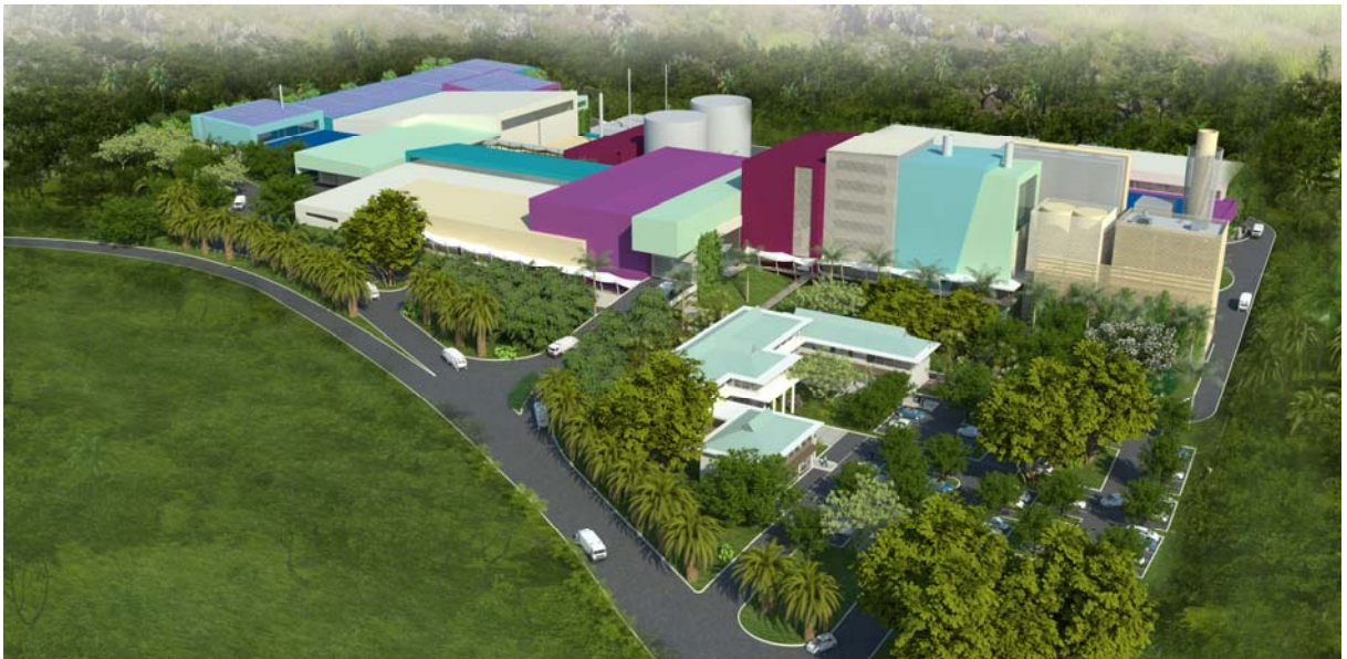
Vue d'ensemble du projet, avec le bâtiment administratif au premier plan
