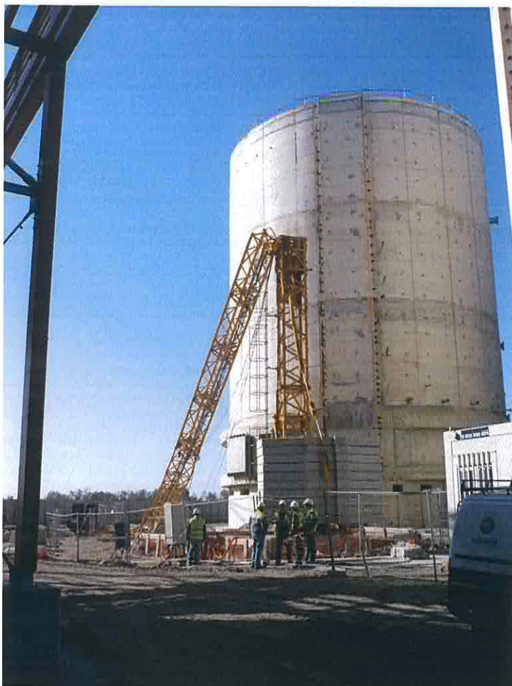
VUE D'ENSEMBLE DIGESTION PRISE NORD EST VERS SUD OUEST
