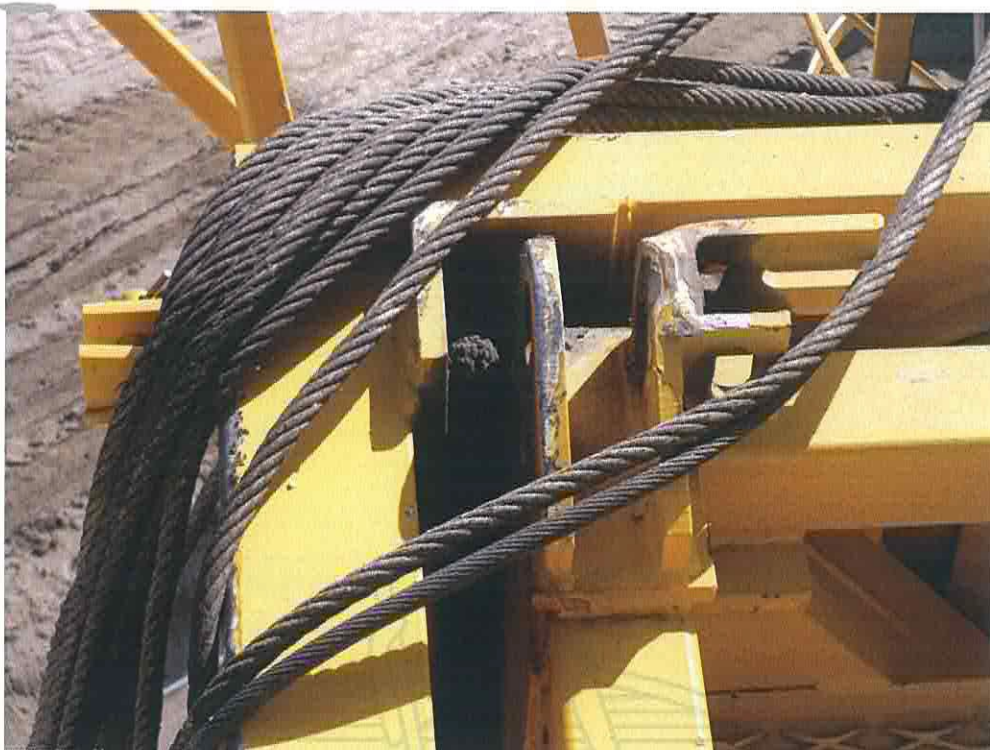
ANCRAGE NORD EST
